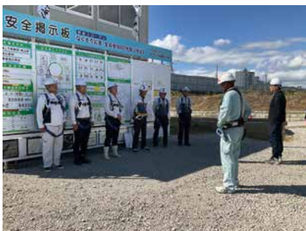
【土木】吹田佐井寺調整池（安全訓示）
