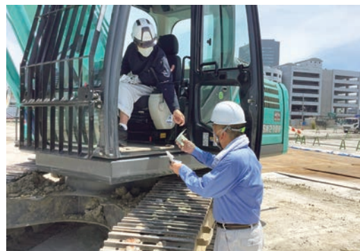
<土木>浴恩園遺跡2作業所 (資格の確認)
