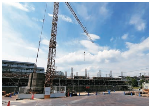
<建築> PFI 平針住宅作業所（工事状況）
