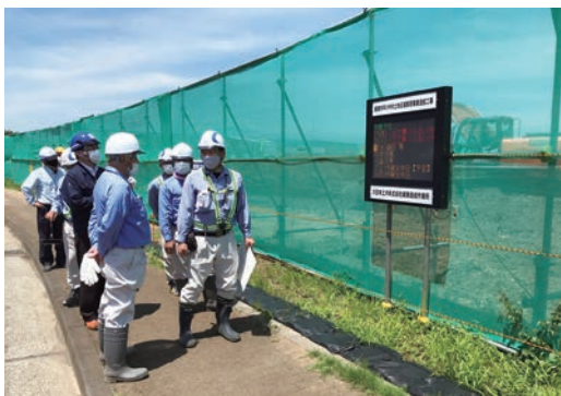
<土木>綾瀬造成作業所 (現場巡視)
