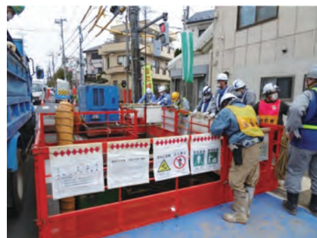
パトロール巡視状況
