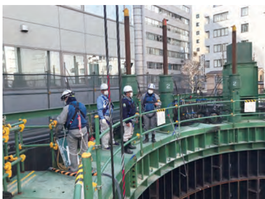
3 班：新富下水立坑作業所（土木）
