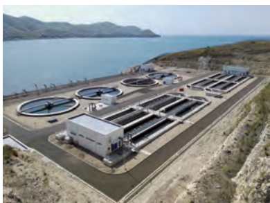
パプアニューギニア（下水処理場）
