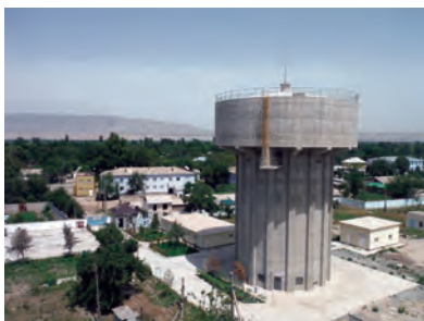
タジキスタン（給水施設）
