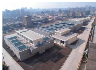
エジプト（浄水場）
