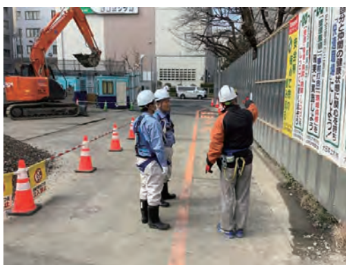
3班：新富下水立坑
