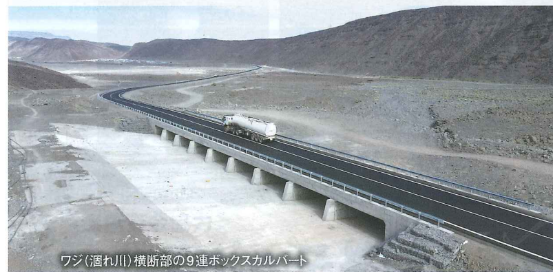
ワジ(酒れ川)横断部の9連ボックスカルバート
